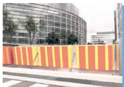
水の浮力を利用して自動起立する自動昇降式・フロート式止水板
