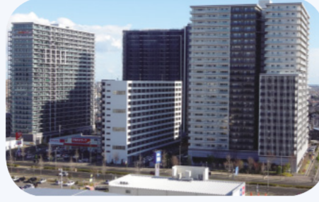
東側と南側の高層マンションにより日が差さない復興公営住宅 (写真中央)
