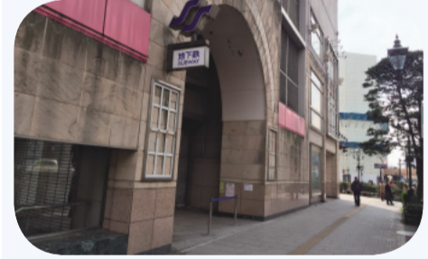
旧さくら野百貨店の地下鉄出入口と市が区分地上権を有している換気塔部分
