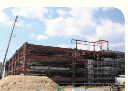
建設が進む地下鉄東西線（仮称）動物公園駅のパークアンドライド駐車場
