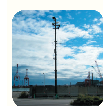
津波情報伝達システムの屋外拡声装置
