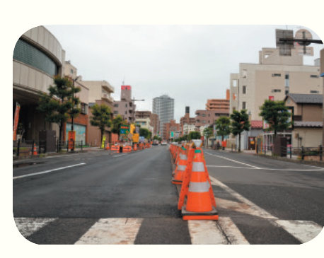
道路復旧工事が進む旧国道4号線（太白区長町）
