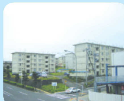
再整備が行われている鶴ヶ谷第一市営住宅団地
