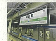
移設工事が始まるJ福田町駅
