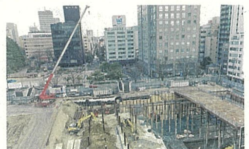
工事が突き進む本庁舎建替事業 (3/17より8階議場横から眺望可能)
