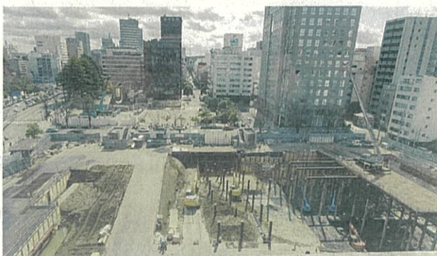
見学スペースから見る本庁舎工事現場
