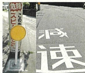
茂庭人来田西の杜都千愛病院付近市道の「減速」路面標示と視線誘導標の再設置
