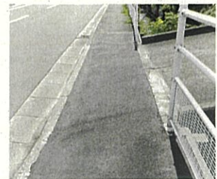
鹿野小通学路の木流堀川沿い歩道の補修(15か所)
