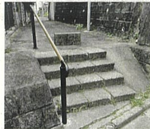
鉤取3丁目22付近階段の手すりの設置
