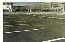
茂庭台市民センター駐車場の 白線引き直しと除草
