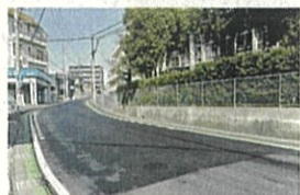
西多賀小通学路の道路舗装・ カラー化の引き直し・路面標示
