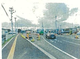
野村工区道路拡幅中
