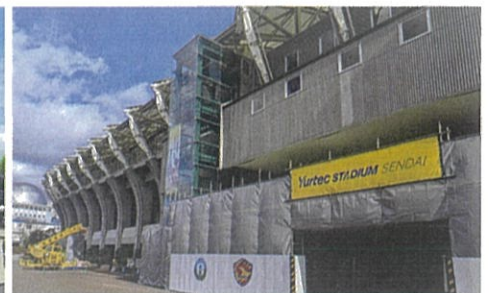
ユアスタ(仙台スタジアム)も改修工事
