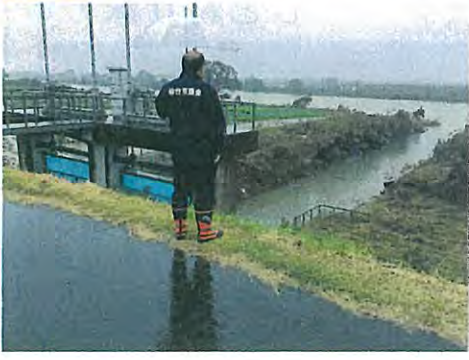
旧笹川から排水される名取川調査 ▼ 2019.10.19
