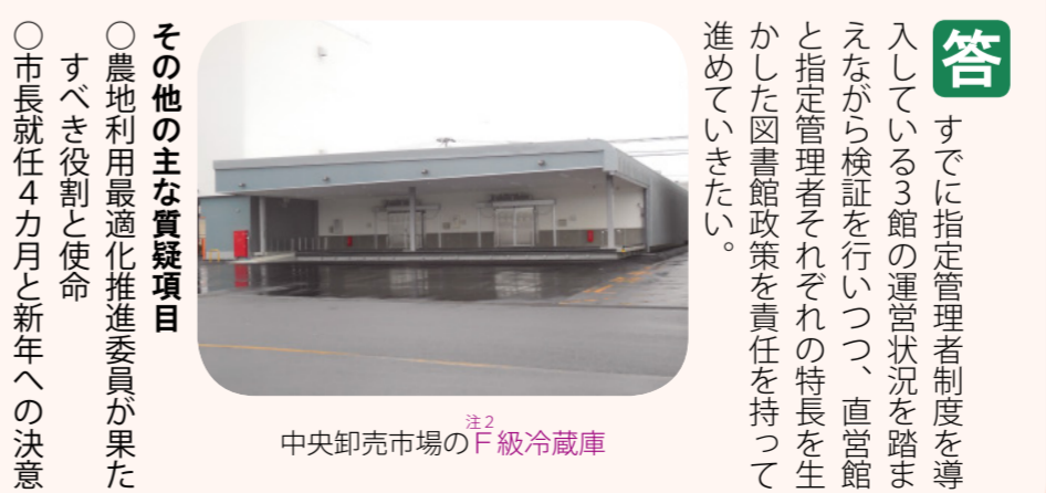
中央卸売市場のF級冷蔵庫
