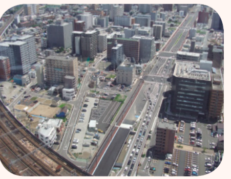
工事完了目前の仙台駅東第二土地区画整理事業
