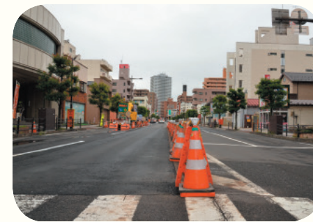
道路復旧工事が進む旧国道4号線(太白区長町)
