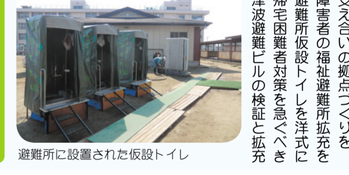
避難所に設置された仮設トイレ
