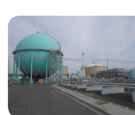
復旧が進むガス局港工場
