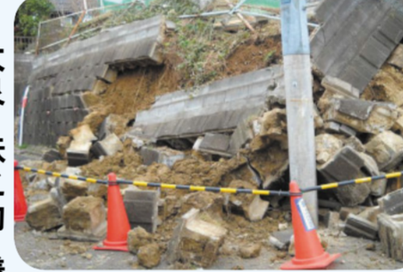
震災で被害を受けた造成宅地
