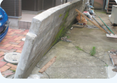
倒壊の恐れのあるブロック塀
