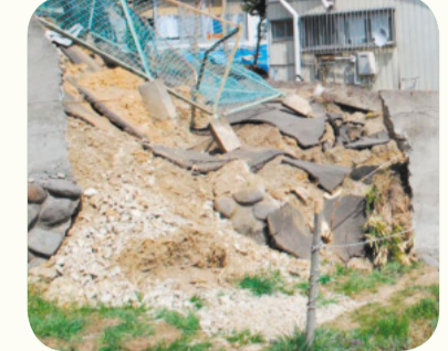
太白区青山地区の宅地被害
