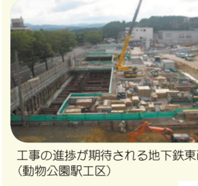
工事の進捗が期待される地下鉄東西線(動物公園駅工区)
