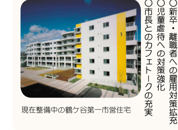
現在整備中の鶴ヶ谷第一市営住宅
