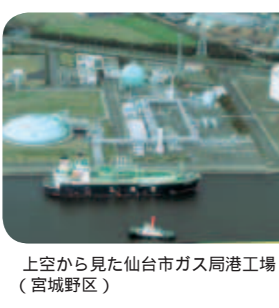
上空から見た仙台市ガス局港工場(宮城野区)
