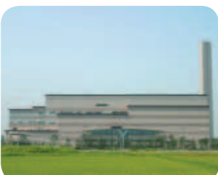
大型焼却炉をもつ松森工場(泉区)
