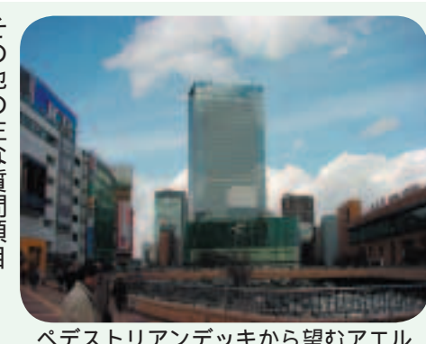
ペDESTリアンデッキから望むアルビル
