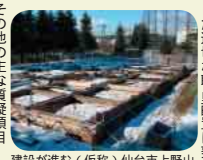
建設が進む(仮称)仙台上野山児童館(太白区) 写真は平成17年12月15日現在(平成18年4月開館予定)
