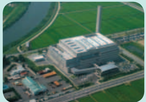
ダイオキシンの類濃度測定を毎月実施することとなった松森工場(泉区)
