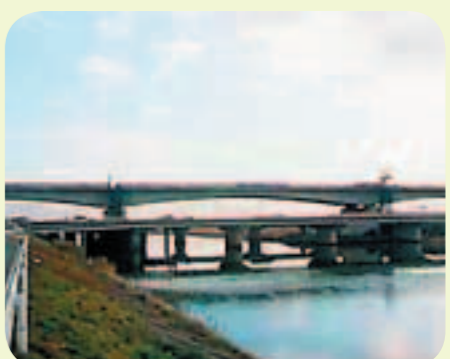
仙台東部高速道路高架橋(宮城野区)(仙台河川国道事務所HPより)
