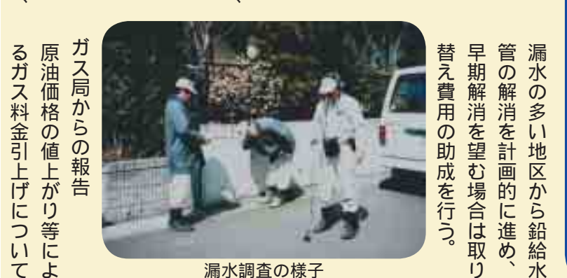
漏水調査の様子
