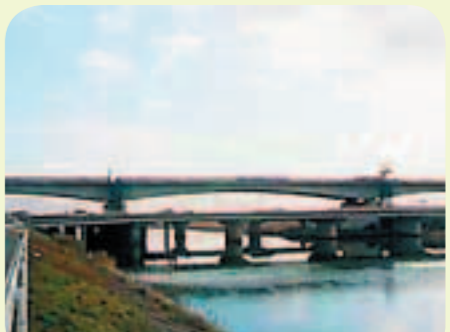
仙台東部高速道路高架橋(宮城野区)(仙台河川国道事務所HPより)
