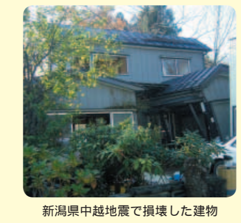
新潟県中越地震で損壊した建物
