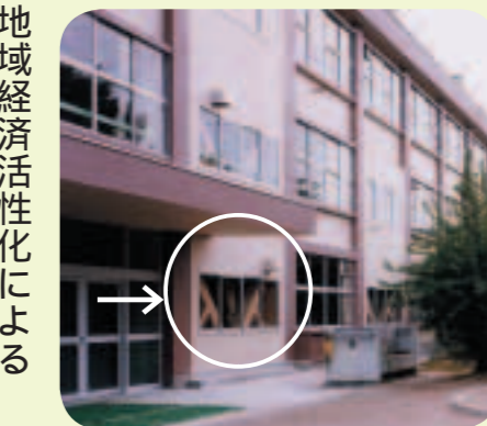
耐震補強工事をした校舎
