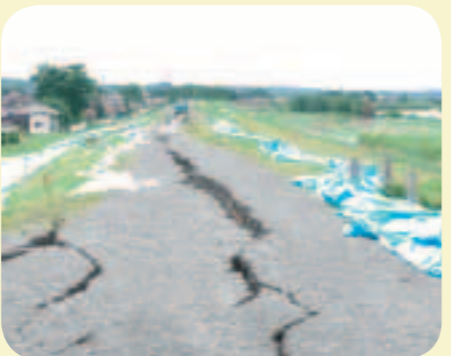
宮城県北部地震で地割れの生じた鳴瀬川堤防の被害状況
