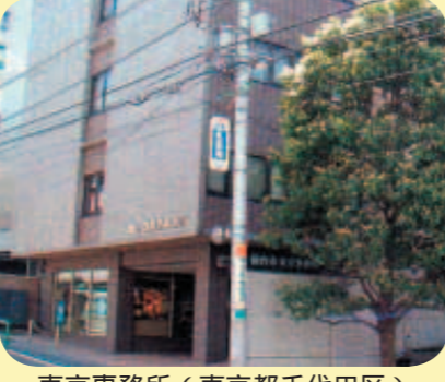
東京事務所(東京都千代田区)
