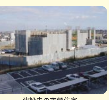
建設中の市営住宅
