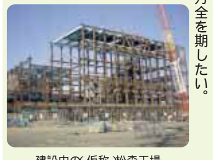
建設中の仮称松森工場
